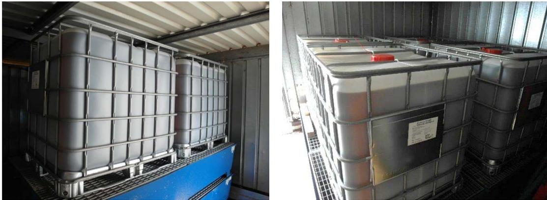
**Abbildung 4-16 und Abbildung 4-17: Kraftstofflager für B100**
